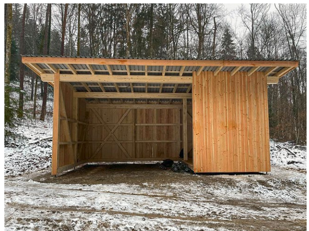
Der fertige Holzlagerschopf.
