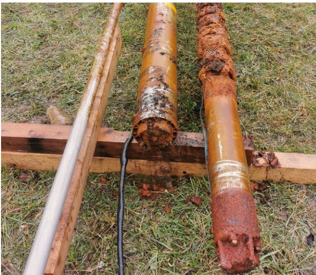
Pumpen mit Verkrustungen und Ablagerungen.
